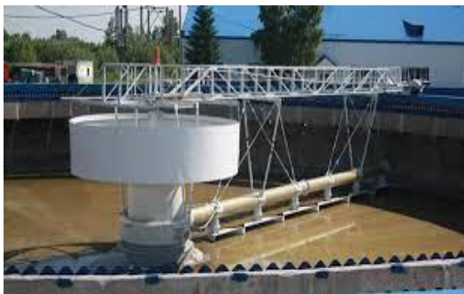
Рис. 3. Радиальный отстойник
