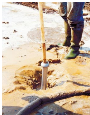
Рис. 8.1. Установка иглофильтров
