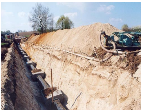
Рис. 8.2. Монтаж вытяжного коллектора
