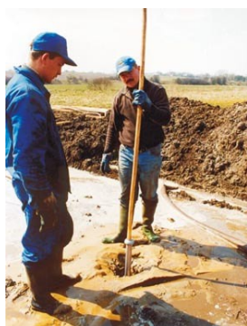
Рис. 8.1. Установка иглофильтров
