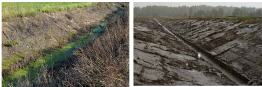
а б Рис. 1. Осушительные каналы: а – без крепления дна и откосов; б – с креплением дна
