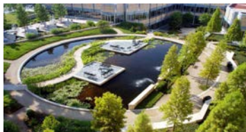
Рис. 1. Инженерные сооружения благоустройства
