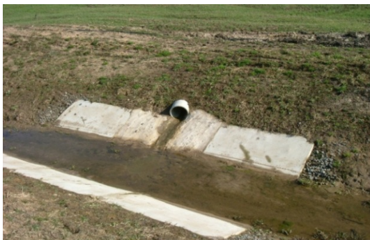
Рис. 3.6. Асбестоцементное дренажное устье
