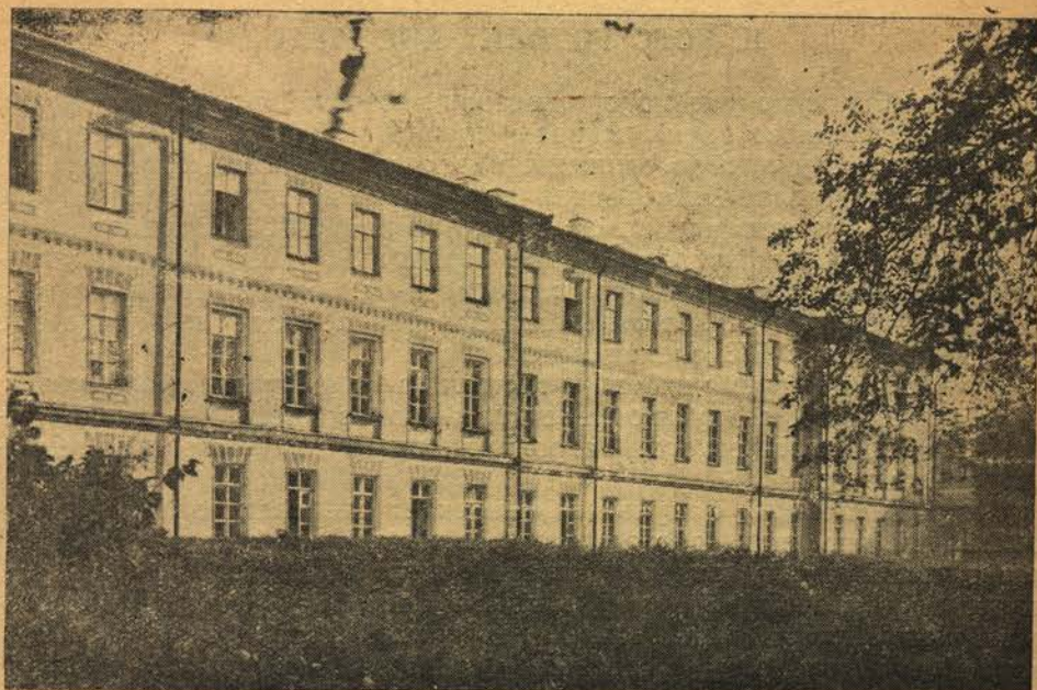
Рис. 1. Здание старого учебного корпуса.
