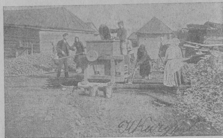
Рис. 29. Дробилка-сортировка (применяемая для добывания огуречных семян) в действии. Сверху человек наполняет машину через приемник из корзины огурцами.
