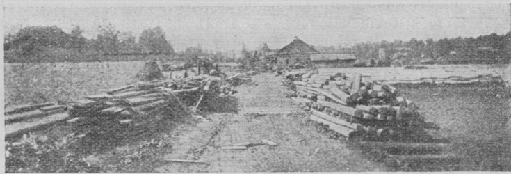
Рис. 84 Доски и бревна (короты), изъ которыхъ состоитъ петербургскій овощной лабазъ, т. е. его сотовъ.
