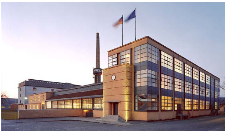
Рис. 51. Здание фабрики «Фагус» в г. Альфельд, Германия (В. Гропиус, А. Майер, 1911–1912 гг.)
