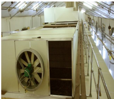
Рис. 95. Теплообменник
