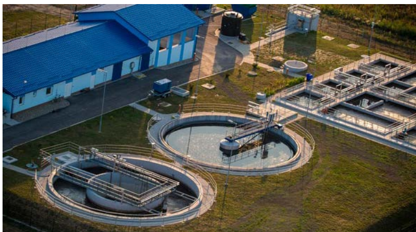
Рис. 34. Современная очистная станция
