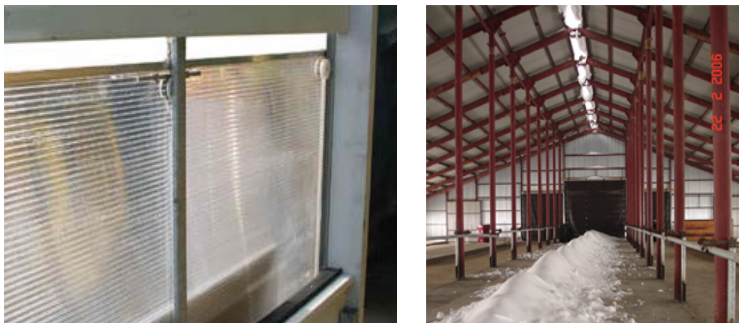
Рис. 30. Подвижные панели из поликарбоната для вентиляции коровника
