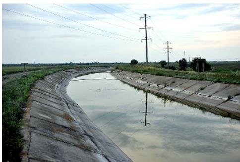
Durch die Befestigung der Sohle und der Böschungen soll erreicht werden, dass der Wasserlauf viele Jahre im Ausbauzustand bleibt.
