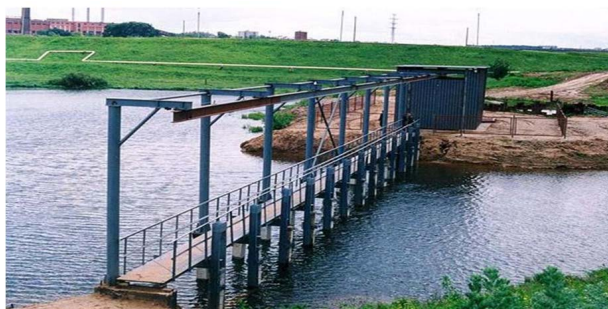
Рис. 7.25. Рыбозащитные сооружения насосной станции Костромской низины
