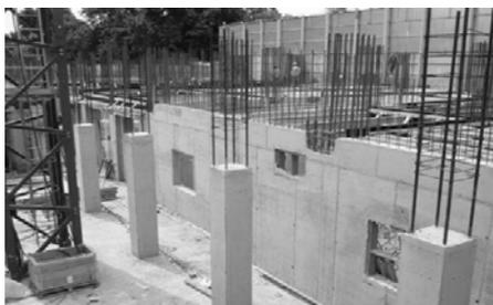
Рис. 1. Здание, построенное методом монолитной заливки
