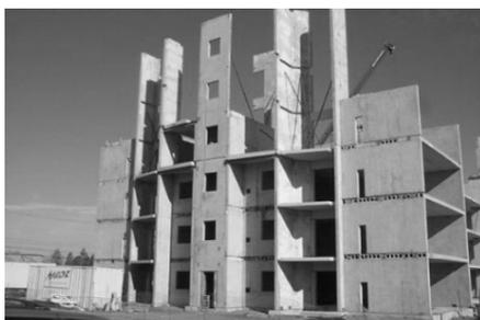
Рис. 2. Здание, построенное с помощью железобетонных плит
