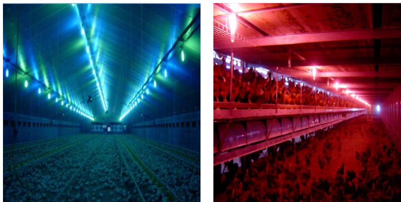
Рис. 21. Система освещения Gasolec Orion: a – сине-зеленая для бройлеров; б – красная для несушек
