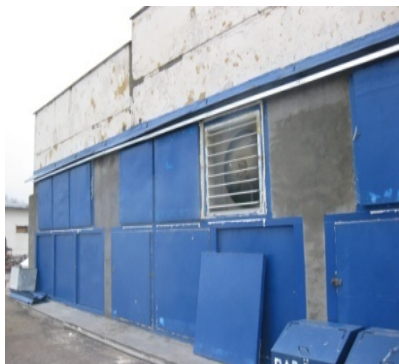
Рис. 14. Вытяжные вентиляторы в заднем торце помещения
