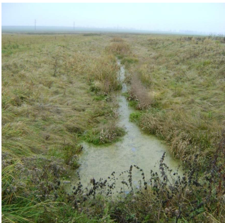
Рис. 1.1. Вид заросшего мелиоративного канала
