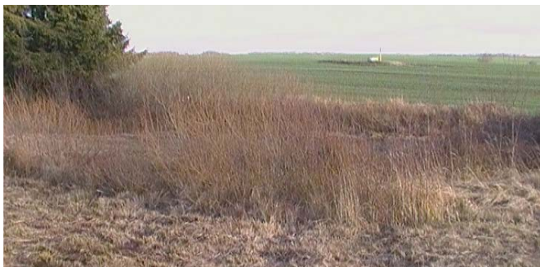
Рис. 1.2. Вид плохо ухоженной придорожной полосы
